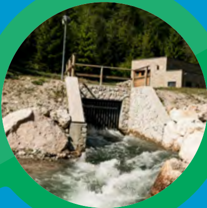
Wasserkraftwerke Venetien II
